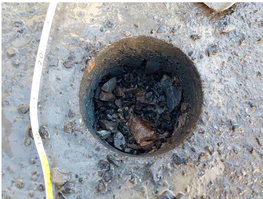
Sonda S2 – povrch vrstvy kamenného podkladu po odebrání jádrového vývrtu a zbytku vsypného makadamu
