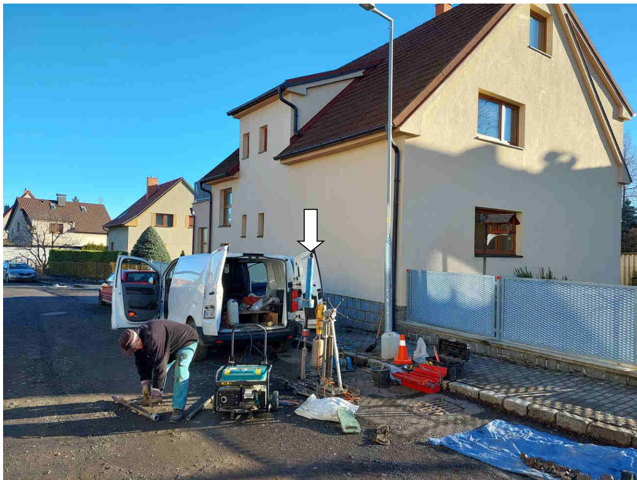
Sonda S2 – situování sondy před č.p. 263
